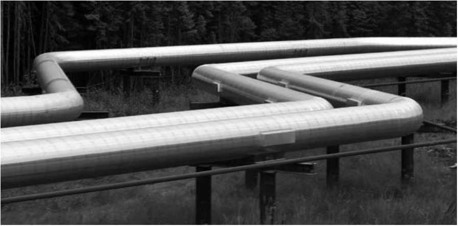
Une partie du hydrogénoduc en construction entre Barcelone et la France.
